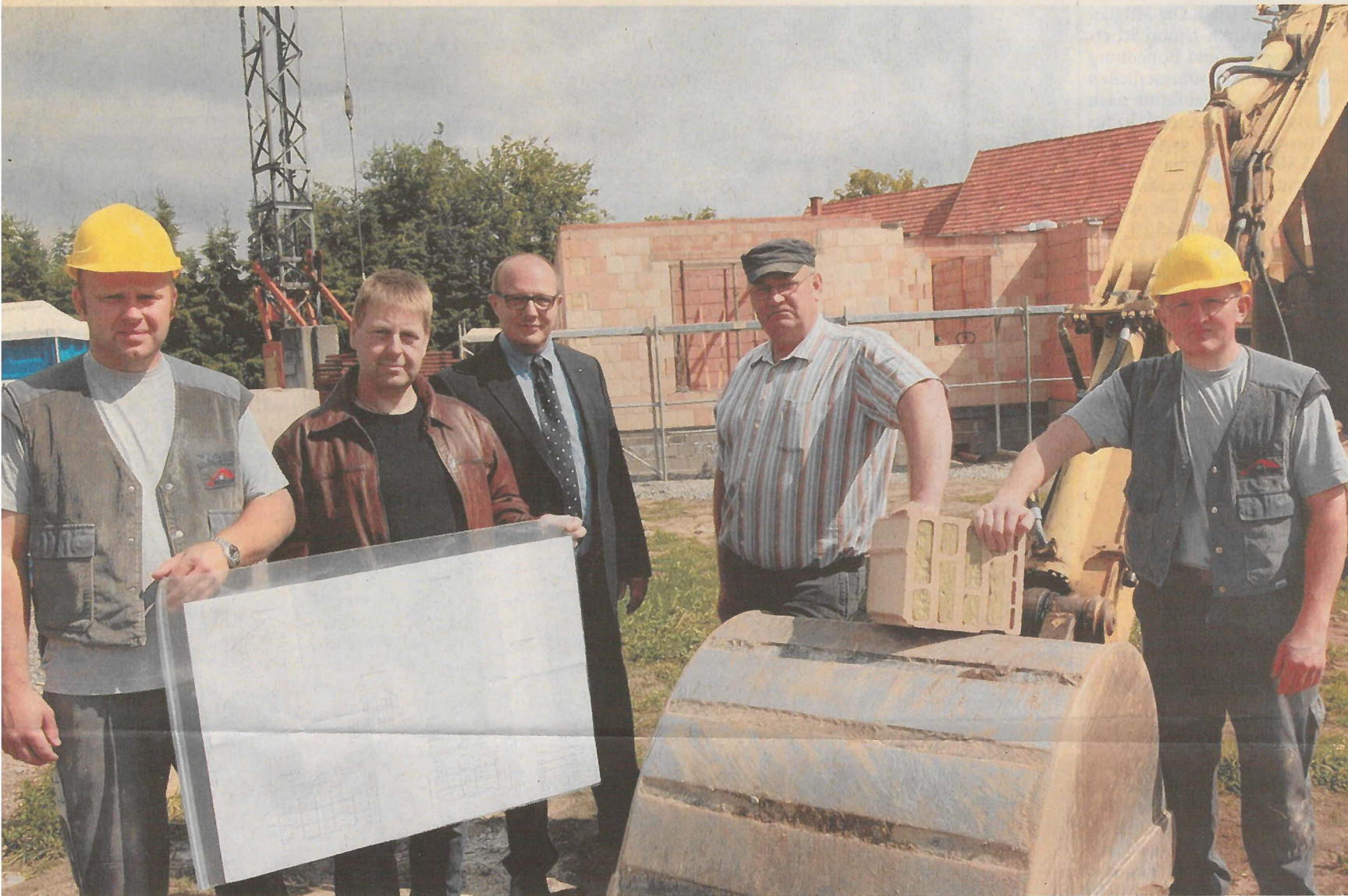
Der Anfang ist gemacht: Das viel diskutierte Bauprojekt am Gänsebruch in Willebadessen macht Fortschritte. Bauunternehmer Peter Neufeld (v. l.), Dipl.-Ing. Kurt Diesterheft, Wolfgang Meyer (Vereinigte Volksbank), Investor Peter Petker und Maurer Johann Klassen vor dem ersten von vier geplanten Miethäusern. FOTO: HERMANN LUDWIG
