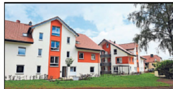
Direkt am Kreuzungsbereich Lange Straße/Gänsebruch wurden diese beiden Wohnhäuser errichtet.
