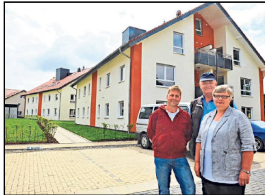
Das Ehepaar Peter und Olga Petker schuf in Willebadessens Ortskern fünf Neubauten. Geplant hat das Bauprojekt der Diplom-Ingenieur Kurt Diesterheft (links).
